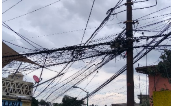
Postes de luz, llenos de cables
